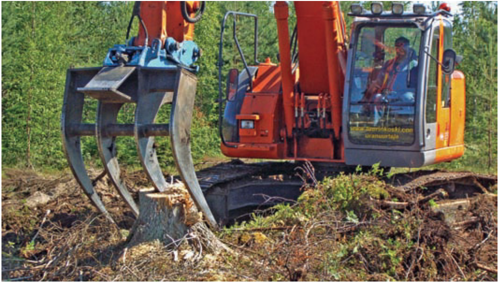
Kannonnosto sujuu parhaiten yli 20 tonnin painoisella kaivinkoneella. (Kuva: Jussi Laurila)
