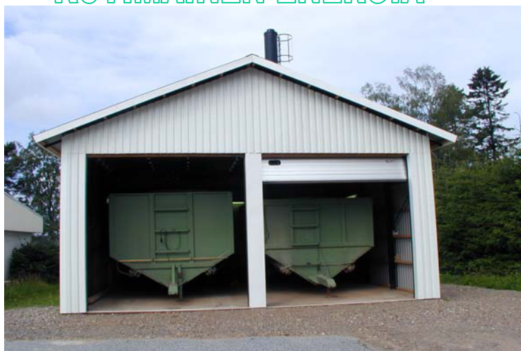
Kuortaneen energiaosuuskunnan 0,7 MW laitos, takana 100 m päässä järvi ja vasemmalla 10 m päässä vanhainkoti/sairaala
