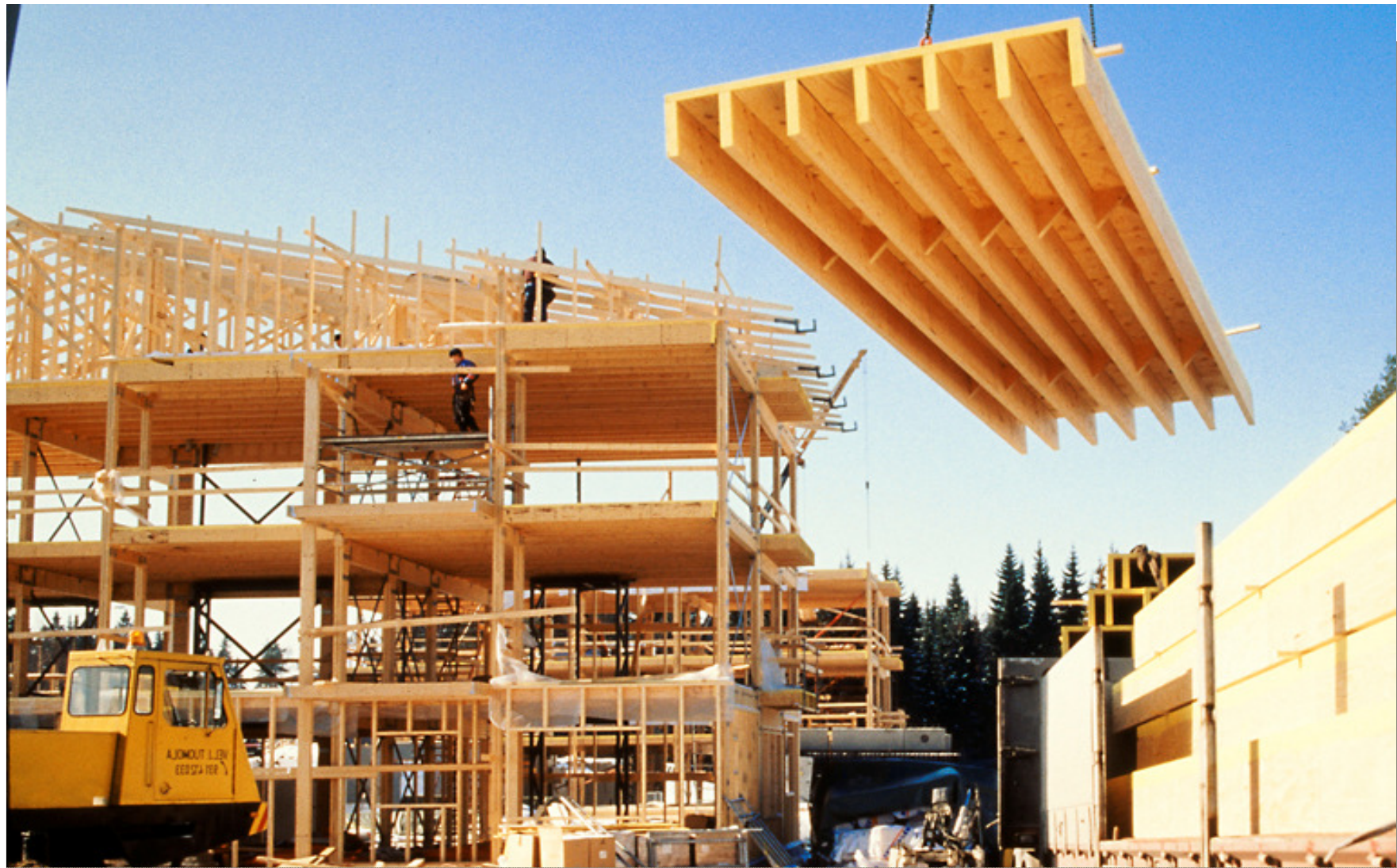
Finnforest Kerto pilari-palkkirunko, Kerto-Ripa välipohjat ja katto Ylöjärven puukerrostalot, 1997
