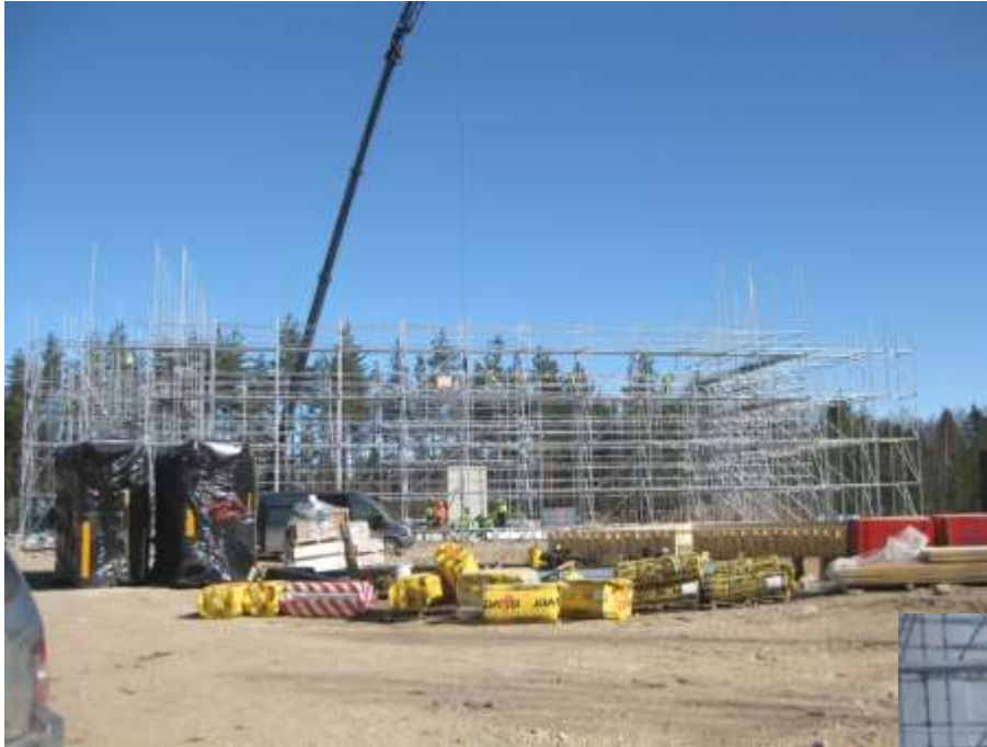
Huhtikuun puoliväli: Asennusteltan ja telineiden pystytys
