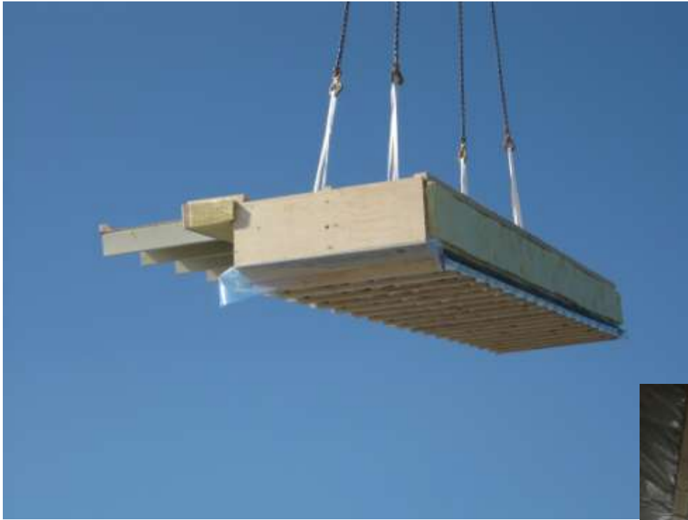
Heinäkuun alku: Yläpohjaelementtien asennus
