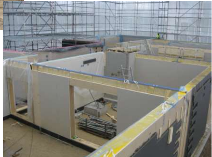
Huhtikuun loppu: Ensimmäisen kerroksen seinäelementit asennettu
