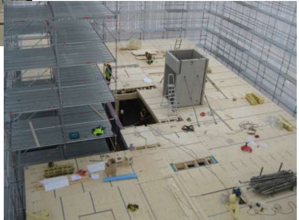
Toukokuun alku: Ensimmäisen kerroksen elementit asennettuina
