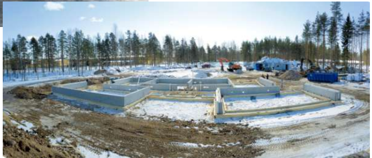
Maaliskuun loppu: Sokkelielementtien asennus
