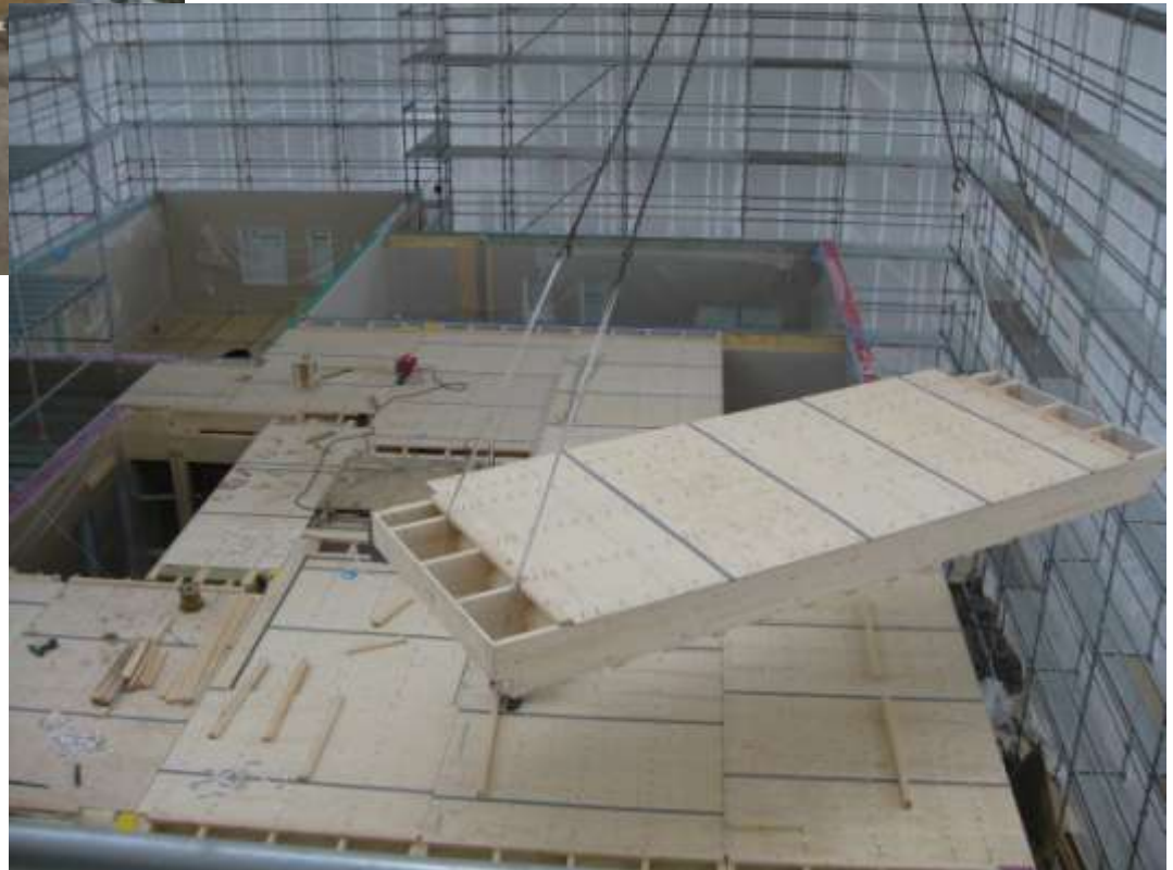
Toukokuun puoliväli: Välipohjaelementtien asennus käynnissä
