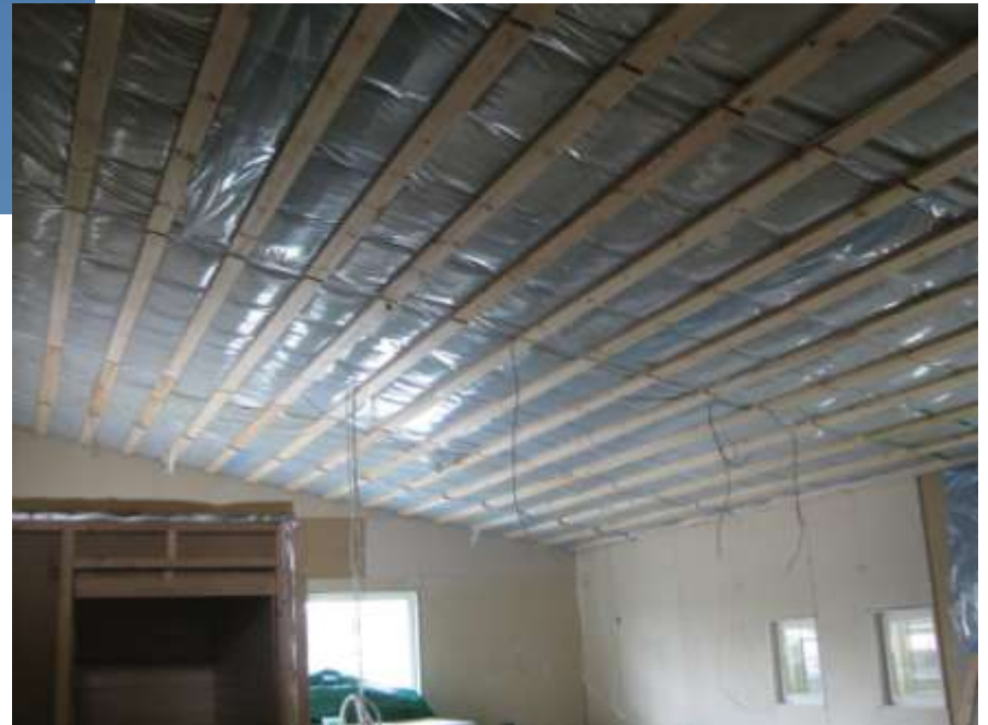
Viidennen kerroksen korkea huonetila
