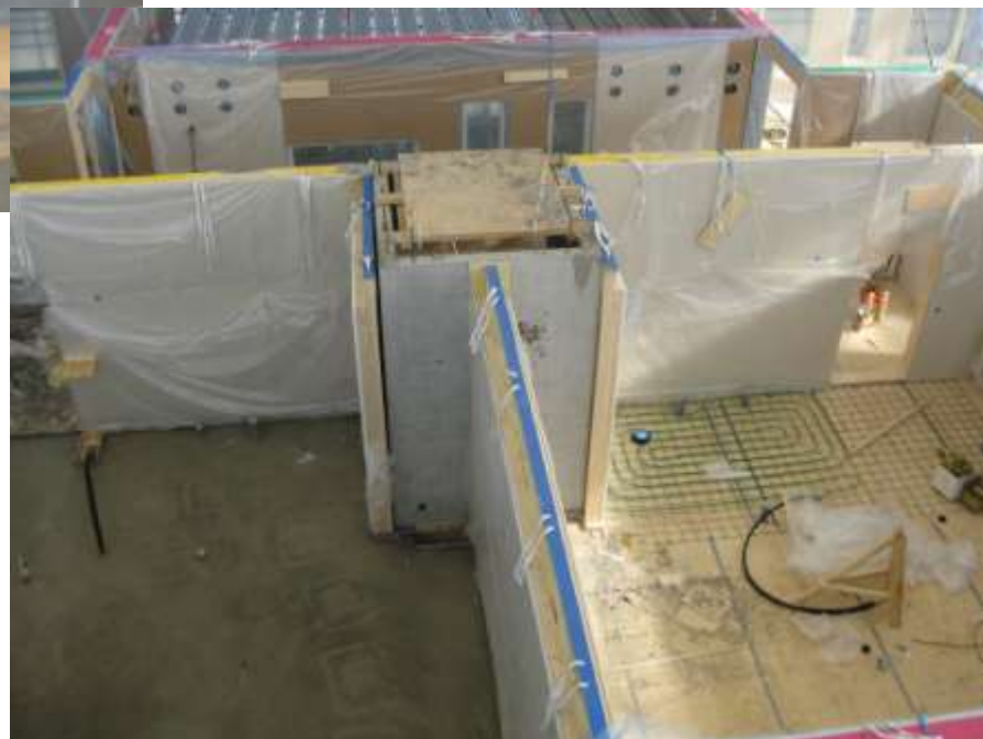
Toukokuun puoliväli: Toisen kerroksen lattiavalu käynnissä
