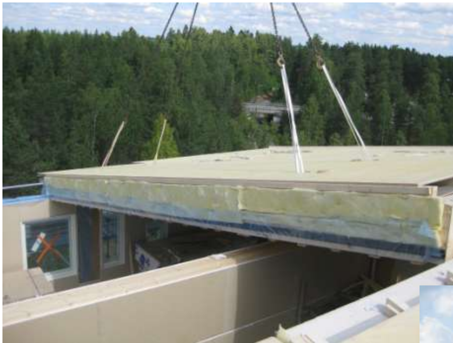
Heinäkuun puoliväli: Viimeisten yläpohjaelementtien asennus
