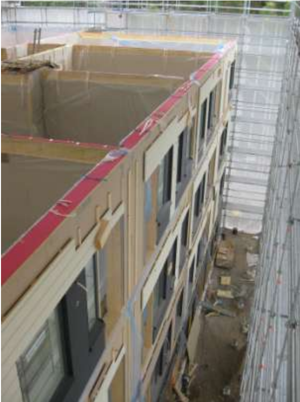
Kesäkuun puoliväli: Neljännen kerroksen seinäelementtien asennus
