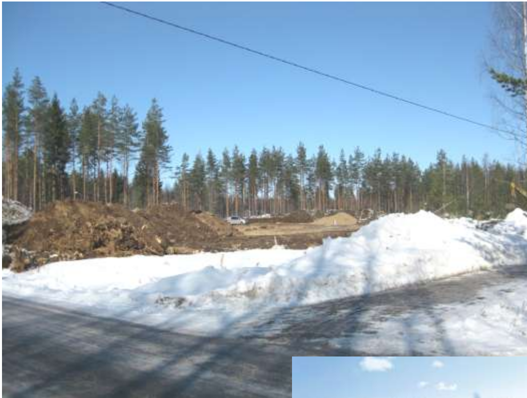
Maaliskuun puoliväli: Maansiirtotyöt käynnissä
