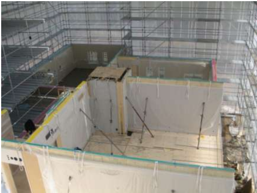
Toukokuun puoliväli: Kolmannen kerroksen seinäelementtien asennus
