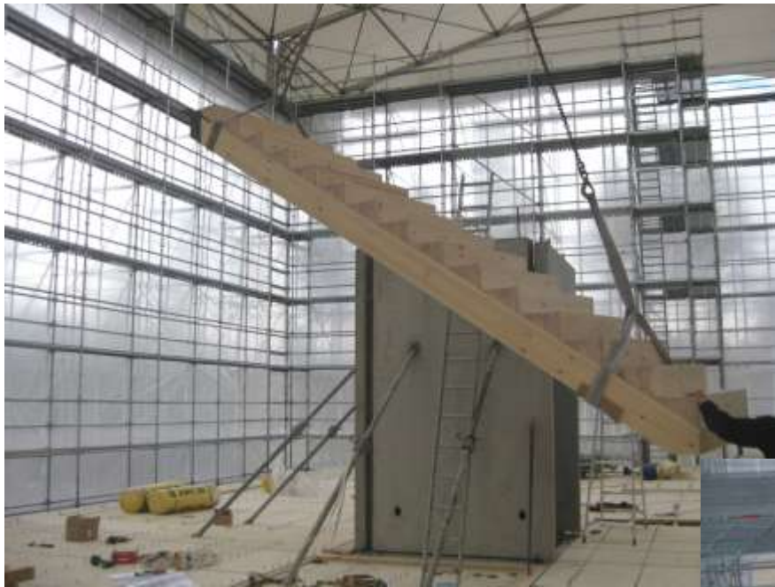
Toukokuun alku: Ensimmäisen porraselementin asennus
