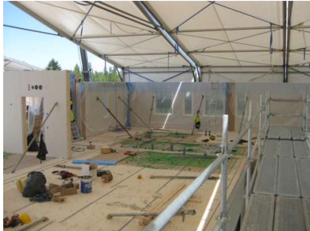
Kesäkuun loppu: Viidennen kerroksen seinäelementtien asennus
