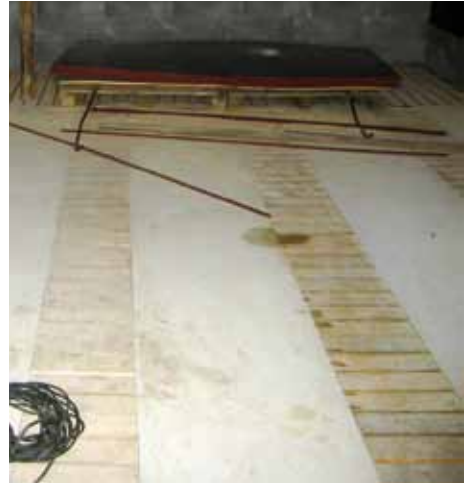
Ilmakanavat lattiavalussa. Sivukanavien leikkauspintojen pinta-ala tulee olla samankokoinen pääkanavan poikkileikkauksen pinta-alan kanssa, jotta ilma jakautuu tasaisesti koko pinta-alalle. (Kuva: Esa Koskiniemi)
