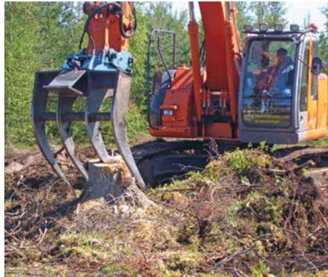
Kuva 6. Parhaiten kannonnostoon soveltuu yli 20-tonninen kaivinkone. Kuva: Jussi Laurila.
