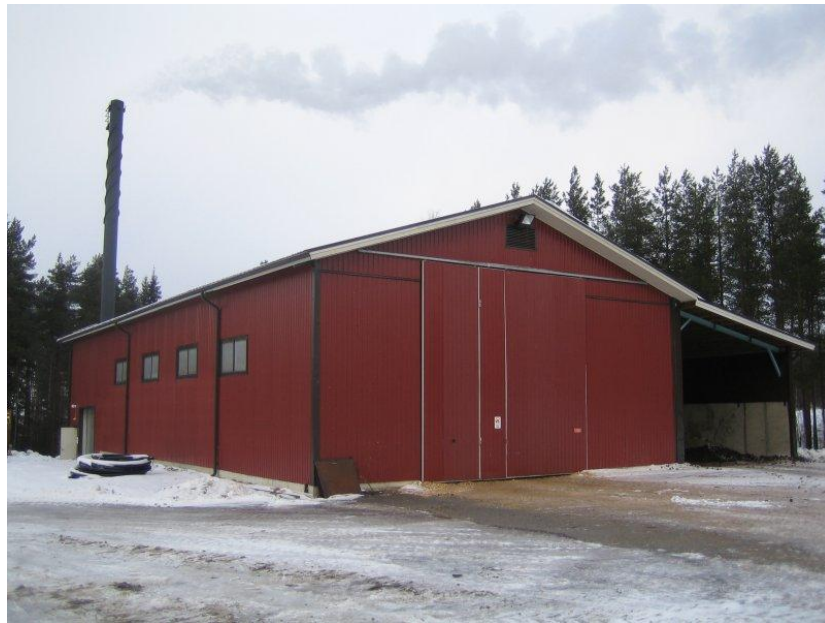
Kuva 3. Lehtimäellä sijaitseva aluelämpölaitos on energiaosuuskunnan omistuksessa. Kuva: Jussi Rintamäki
