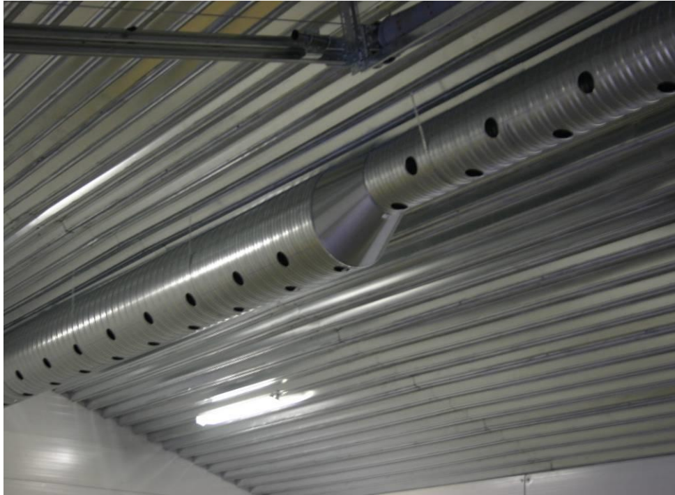
Kuivausilman tulokanava katossa
