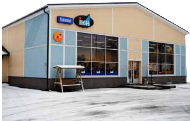
◀ Asiakkaan toiveiden mukaisesti räätälöity Ryhti-halli liikerakennuksena
