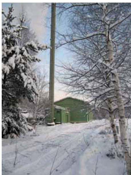
Aluelämpölaitos (Kuva: Tanja Lepistö)
