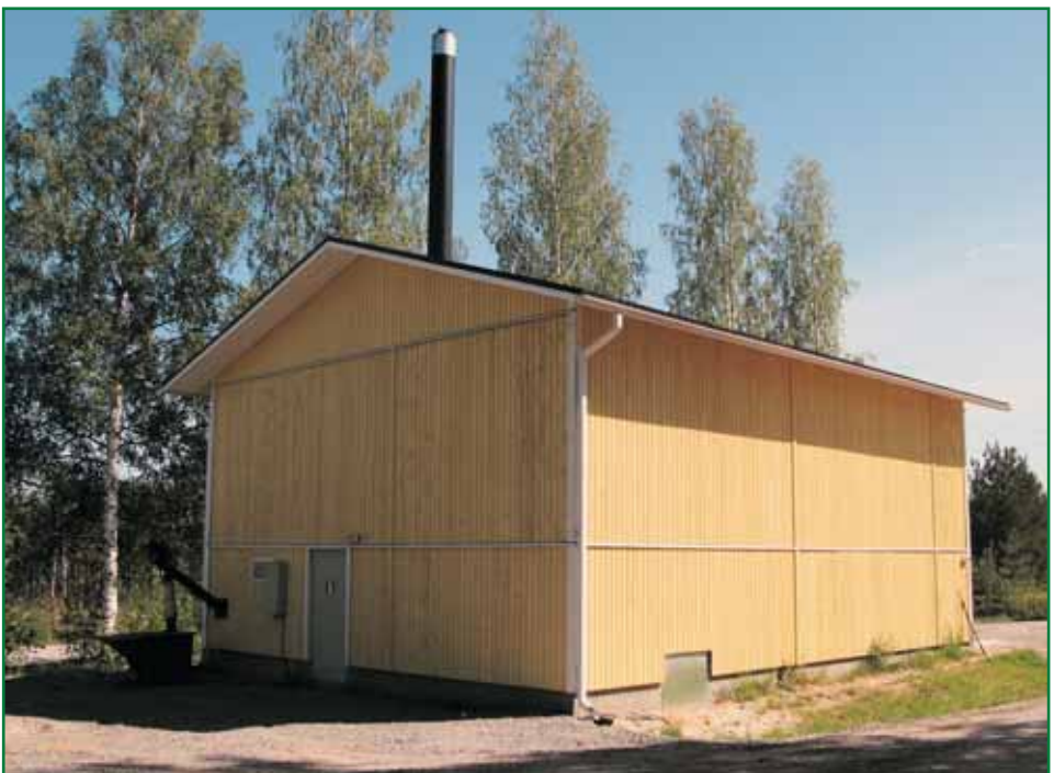
250 kW paikalle rakennettu lämpökeskus. Yläkuvassa rakennus perustusvaiheessa.
