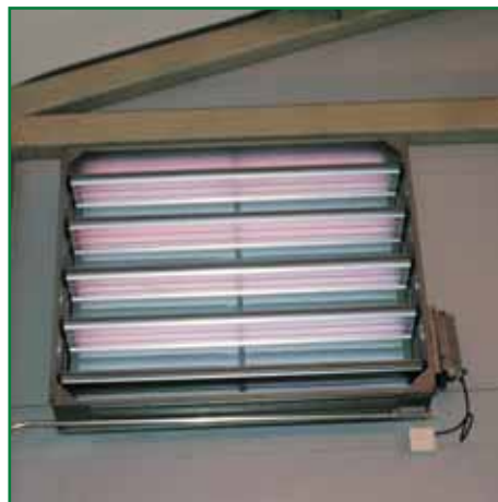
Korvausilmakanavan tulee olla vähintään 1,5-kertainen savuhormin poikki-pinta-alaan verrattuna.
