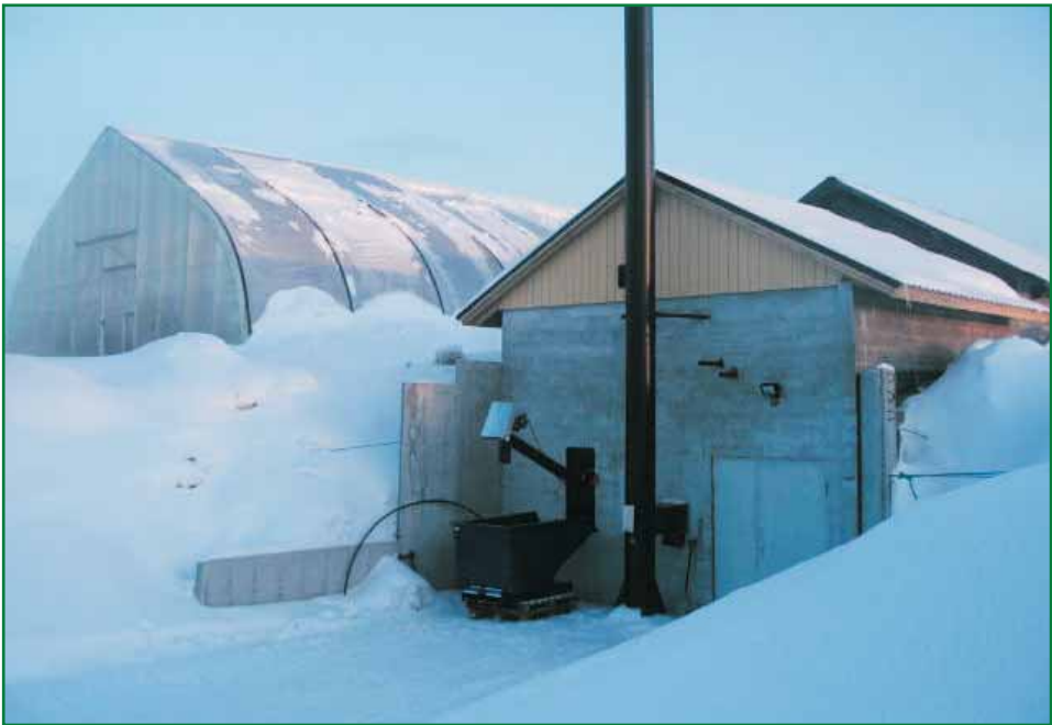
Uudet hakelämpökeskukset suositellaan rakennettavaksi erilleen tuotantorakennuksista.
